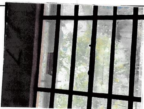
Foto 11: Sustitución de vidrio
