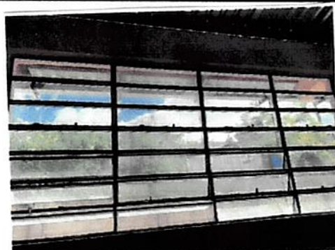
Foto 10: sustitución de vidrios
