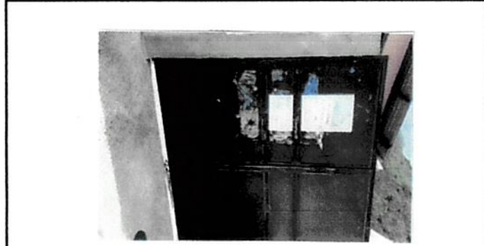
Foto 16: Mantenimiento a estructura a porton
