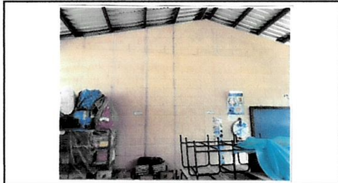
Foto 14: Pintura en muros exteriores e interiores
