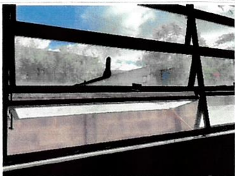
Foto 9: Sustitución de vidrios
